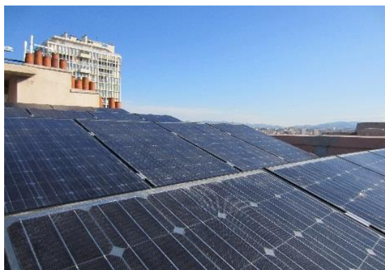
Fixation sur toit terrasse
