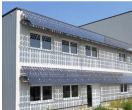
Intégration sur brise-soleil. Source Soltech
